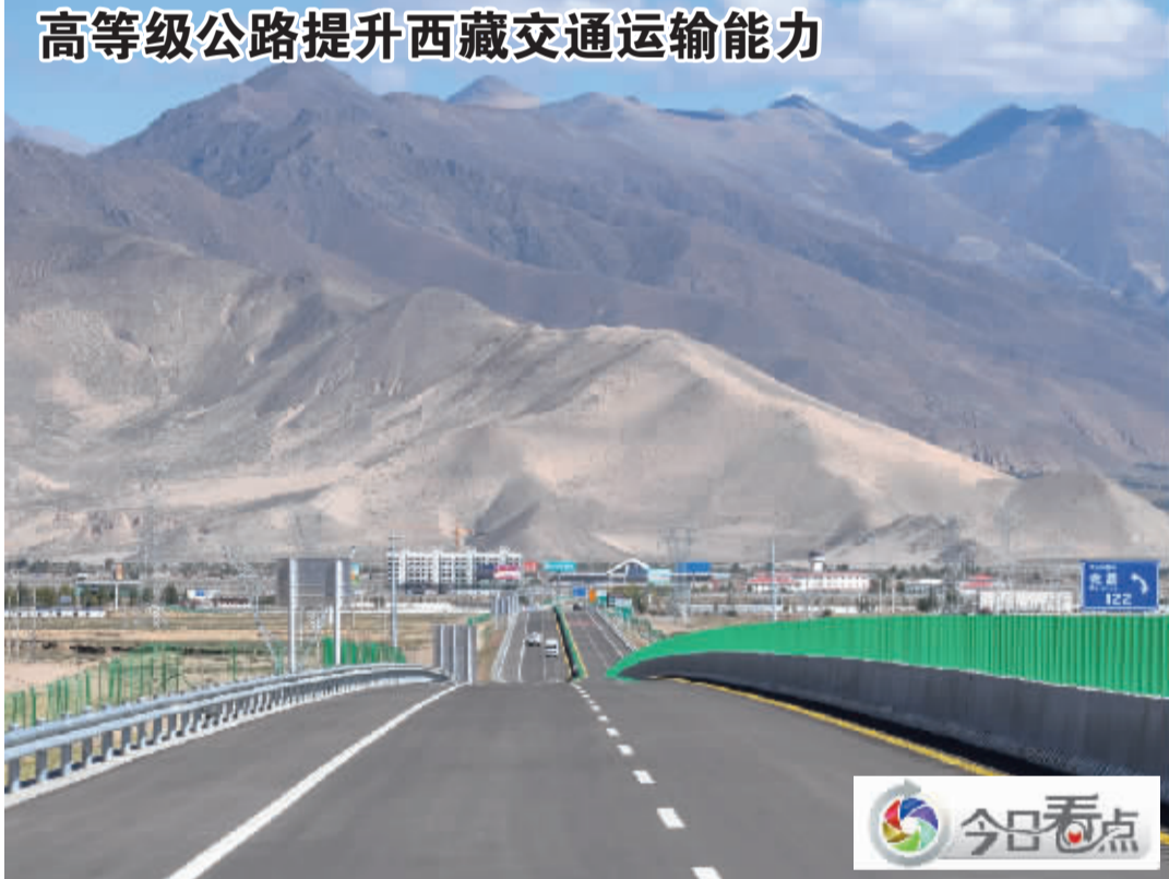
图为日喀则机场至日喀则市区的高等级公路。近年来，西藏先后投资建设林芝至拉萨、日喀则机场至日喀则市、泽当至贡嘎机场、拉萨环城路等7个一级公路项目。截至目前，西藏一级以上公路通车里程达到613公里。
