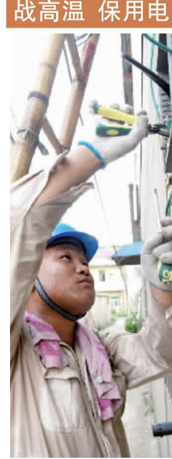
昨天，谷阳供电所施工人员冒高温在金河村开展接户线改造，将破旧铝线更换扩容成铜芯线，提升82户村民用电的安全性。 辛一 吴所华 摄影报道
