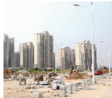
富润华庭五区一期进入配套施工阶段
