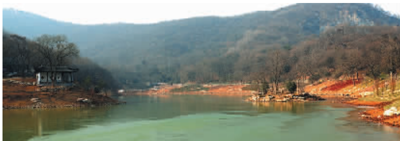
竣工后的珍珠湖片区全景。
