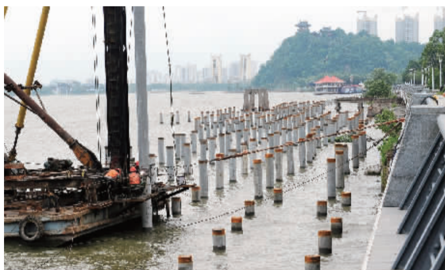
昨天，春江潮广场长江路北侧施工人员正在江面冒雨完成桩基施工任务。据了解，长江路生态环境提升工程已于今年3月中下旬开工建设，年内完工。其中包括沿线路街景美化、亮化、绿化提升，亲水栈道、生态湿地建设。该项目位于长江路北侧，南起解放路（解放路泵站），北至中华路（交会处）。 纪晨 陆智国 摄影报道
