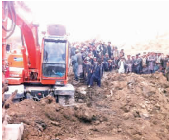
山体滑坡现场救援。
