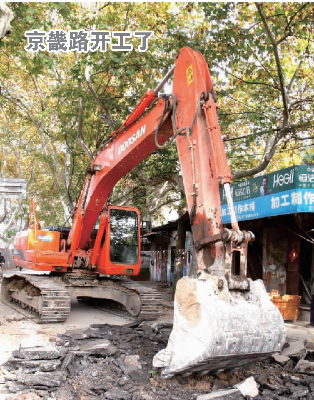
京畿路改造工程开工，大型机械开始破除原有路面。该路全长535米，道路设计时速20公里，车行道宽7米，左右人行道各宽约1米，全封闭期间，施工人员重点实施管线更新改造，为云台山片区保护更新作基础设施方面的铺垫和准备。
