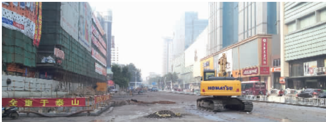
大市口地下连通工程路面部分正在恢复。陈志奎 摄
