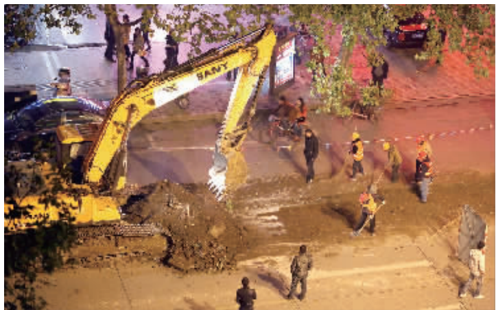
昨晚，工人们将中山东路南半幅的绿岛铲掉，平整路面。石小刚 摄
