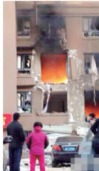
图为爆炸起火现场
